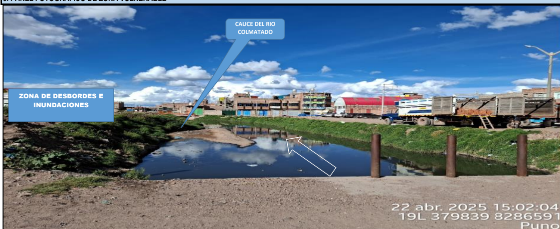
FIGURA 1 y 2 : TRAMO CRÍTICO EN EL RÍO TOROCOCHA, EN LOS SECTORES SAN ISIDRO, SANTIAGO Y LOS ÁNGELES, DISTRITO DE JULIACA, PROVINCIA DE SAN ROMAN - PUNO. NOTESE, LA ACUMULACION DE MATERIAL SEDIMENTADO EN EL CAUCE, QUE REQUIERE SER ELIMINADO PARA REESTABLECER LA SECCION HIDRAULICA DE LA CAJA DEL CAUCE EN ESTE SECTOR.
